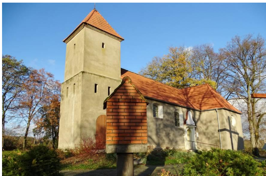
Bytowo, kościół pw. Św. Wojciecha BM, fot. 2023
