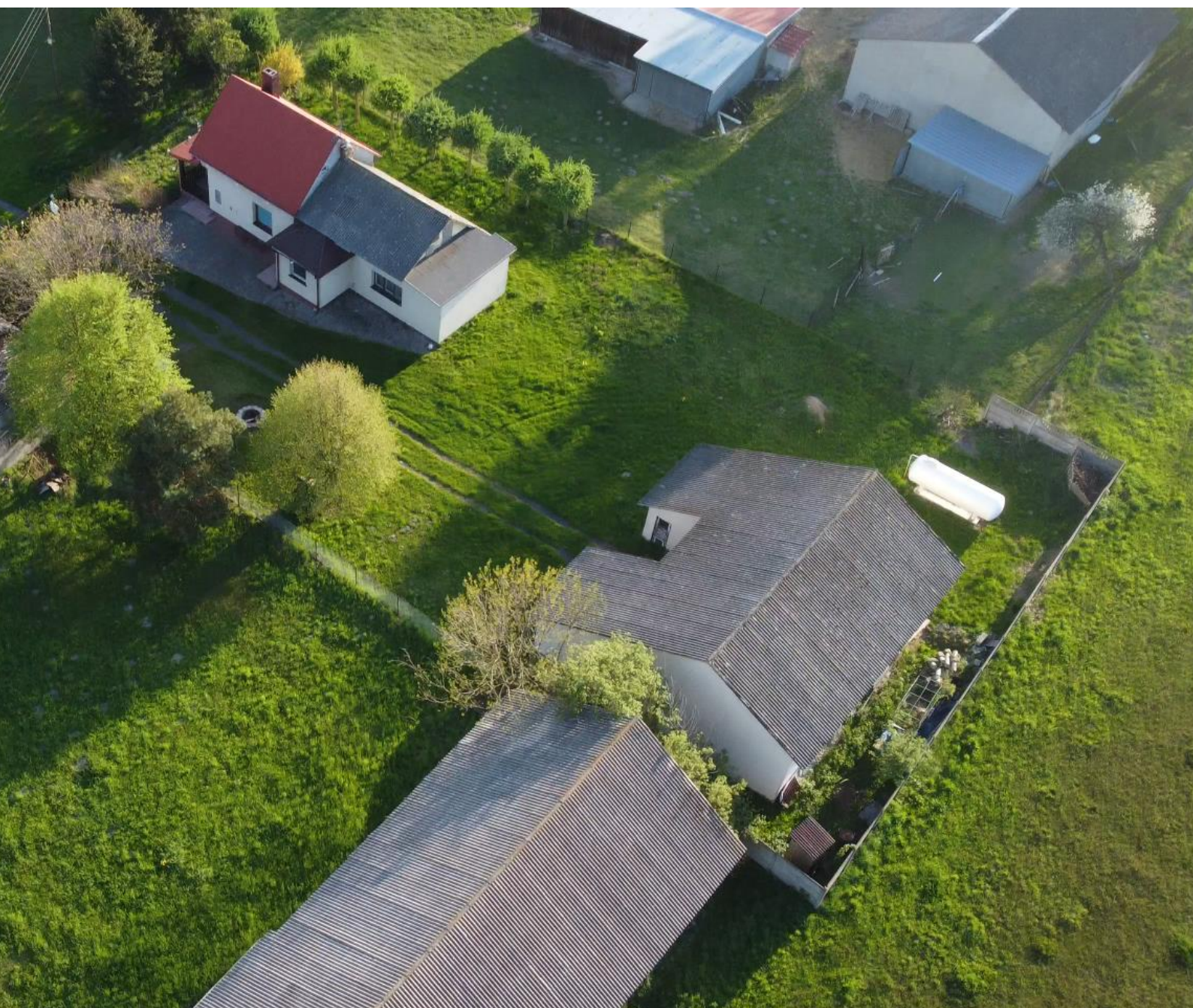
Fot. 1. Wykorzystanie wyrobów azbestowych jako pokrycia dachowe.
